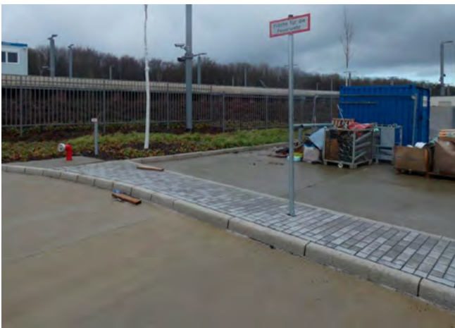
Im Bereich des Zauns befinden sich an zentralen Punkten Saugstellen für die Löschwasserversorgung. Das Löschwasser wird aus dem Wassergraben (hinter dem Zaun) gesaugt. Die Bewegungsflächen an den Saugstellen sind entsprechend gekennzeichnet.
