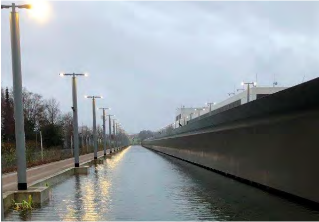
Rückseite des Grundstücks zu den Nachbarflächen des Materialprüfungsamtes. Auch hier hat der Wassergraben eine Breite von 10m und dient uns zur Löschwasserentnahme sowie der Objektsicherheit. Die geschotterte Fläche ist mit Großfahrzeugen nicht befahrbar.
