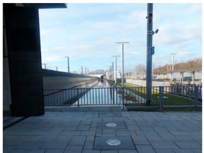
Blick von der Fahrzeugschleuse (Hauptzufahrt) über den Wassergraben. Der Wassergraben hat eine Breite von 10m. Der Grünstreifen rechts neben dem Wassergraben ist mit Großfahrzeugen nicht befahrbar. Im vorderen Bereich sieht man in der Hauptzufahrt vier versenkbare Poller vor unserer Fahrzeugschleuse.
